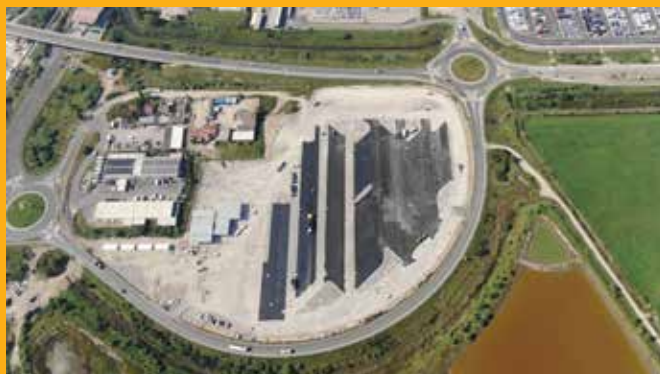
Gradnja zunanjega kamionskega terminala – faza 1A in vgradnja fliša na območju kaset 6A in 7A
